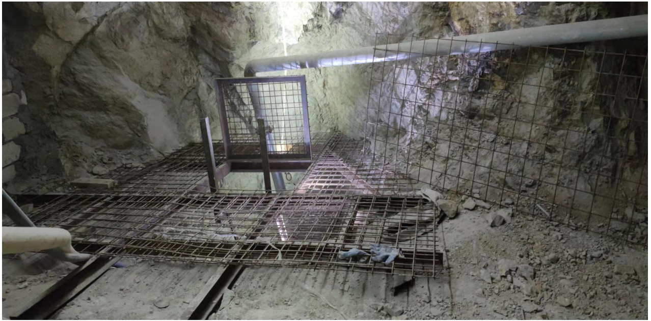
人行回风天井出口
