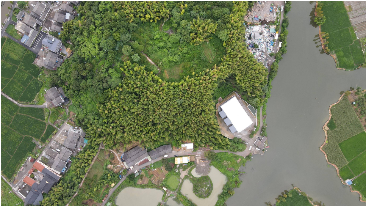
现场勘察时的仓库航拍图
