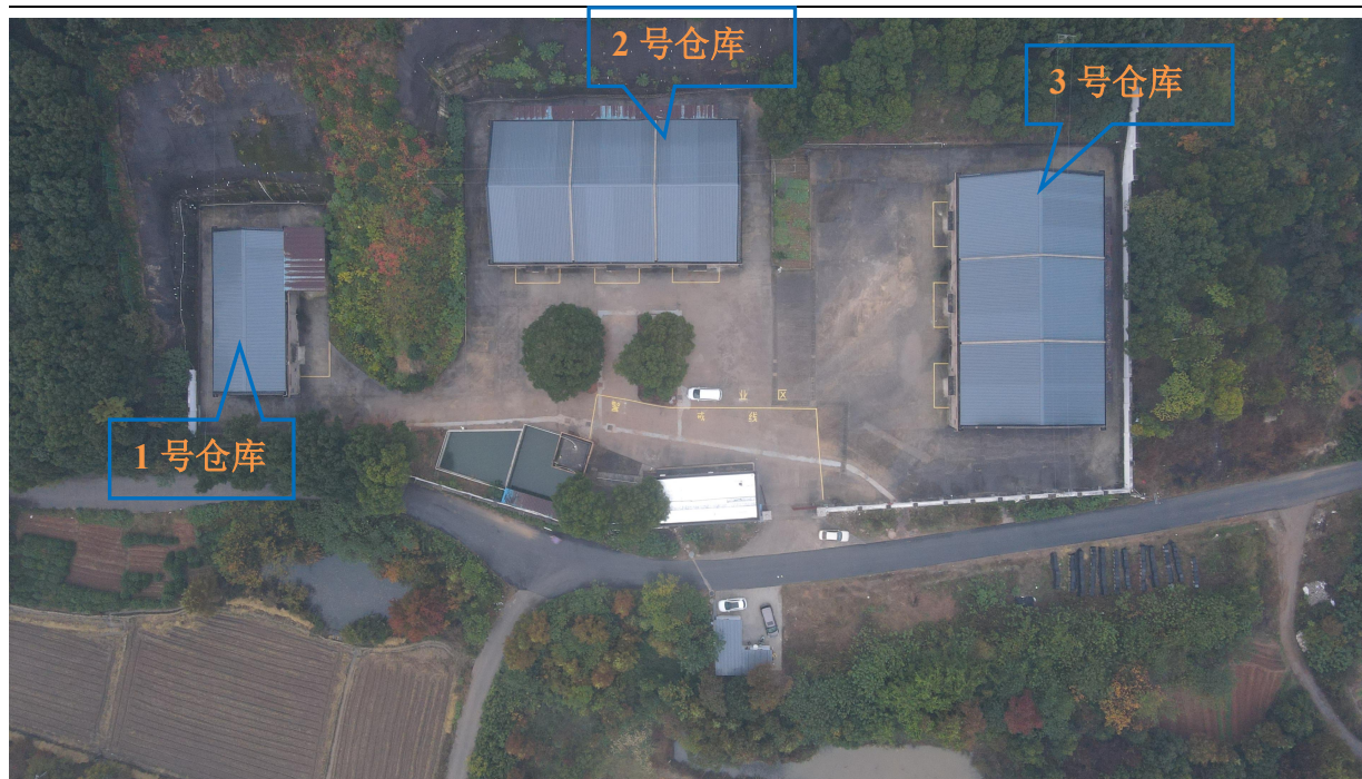
现场勘查时的库房航拍图
