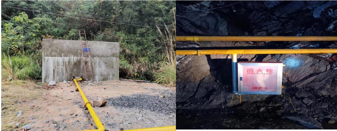
高位水池和井下消火栓
