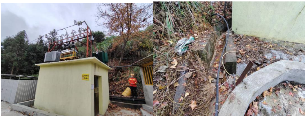
井上变压器及接地
