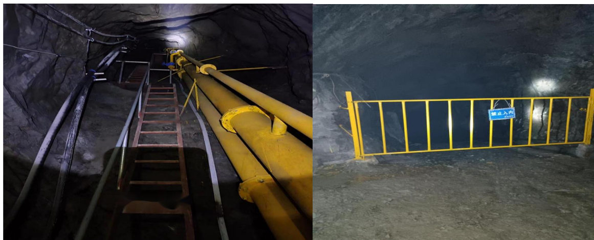
+80m 中段水泵房第二出口、管道井和+80m 中段水仓
